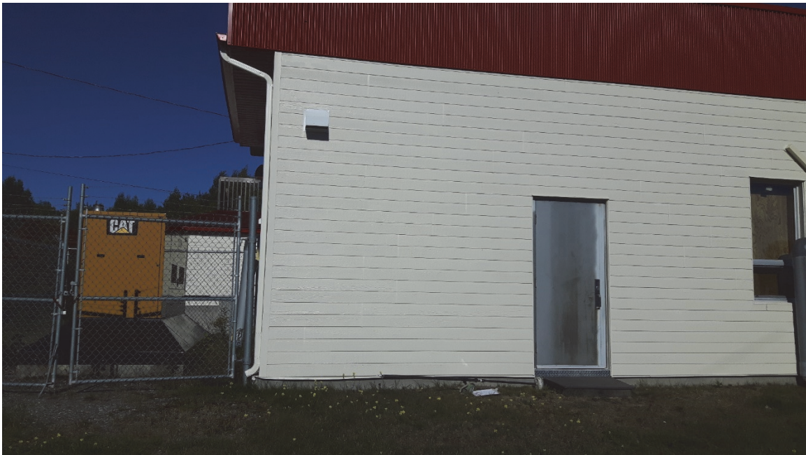
Photo 2 : Aperçu du bâtiment de production d'eau potable – 2020-09-17
