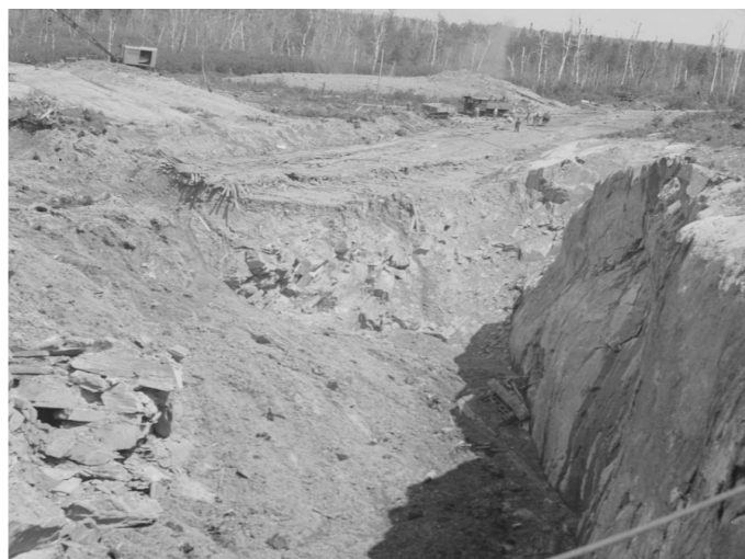
Photo 2 : Éboulement du mur nord du Glory-Hole (source BAnQ)
