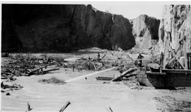
Nettoyage de glaise au chantier Glory-Hole septembre 1944 (source Archives Nationale BANQ)
