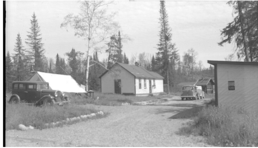
Photo 2 : Bureau de la mine Golconda dans le 9-Milles (source BAnQ)
